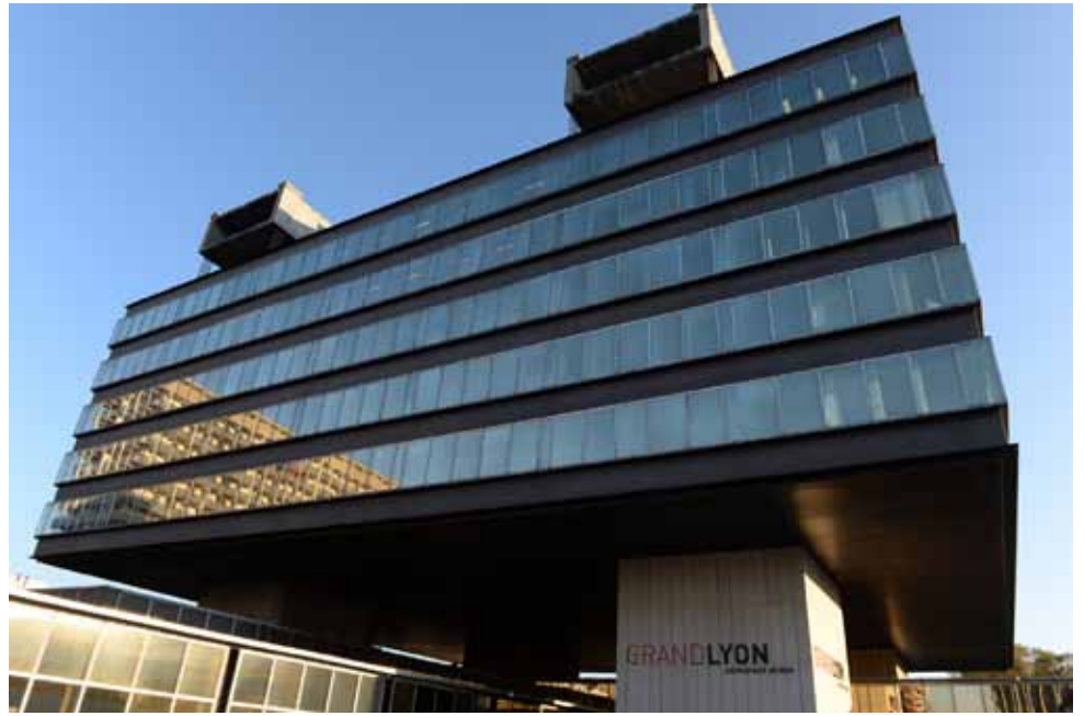
Siège de la communauté urbaine du Grand Lyon
