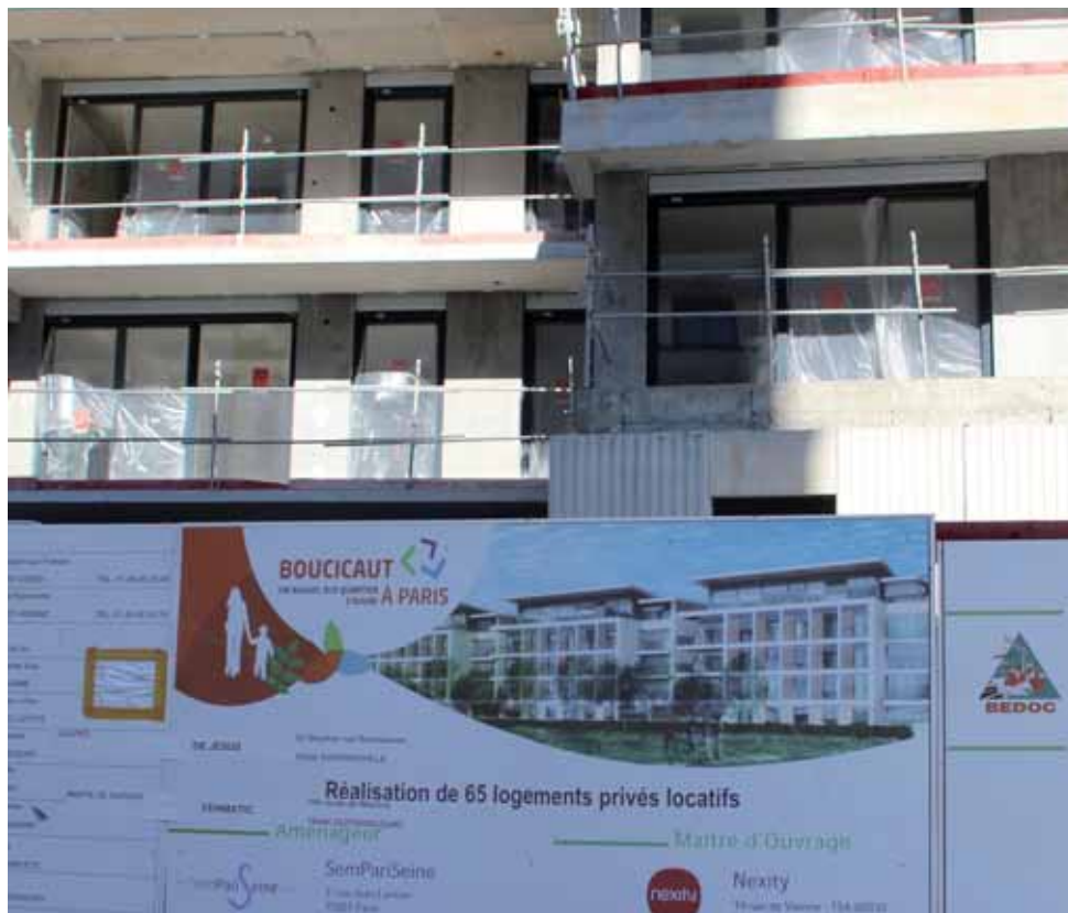
L'opération Boucicaut en cours de réalisation à Paris.
