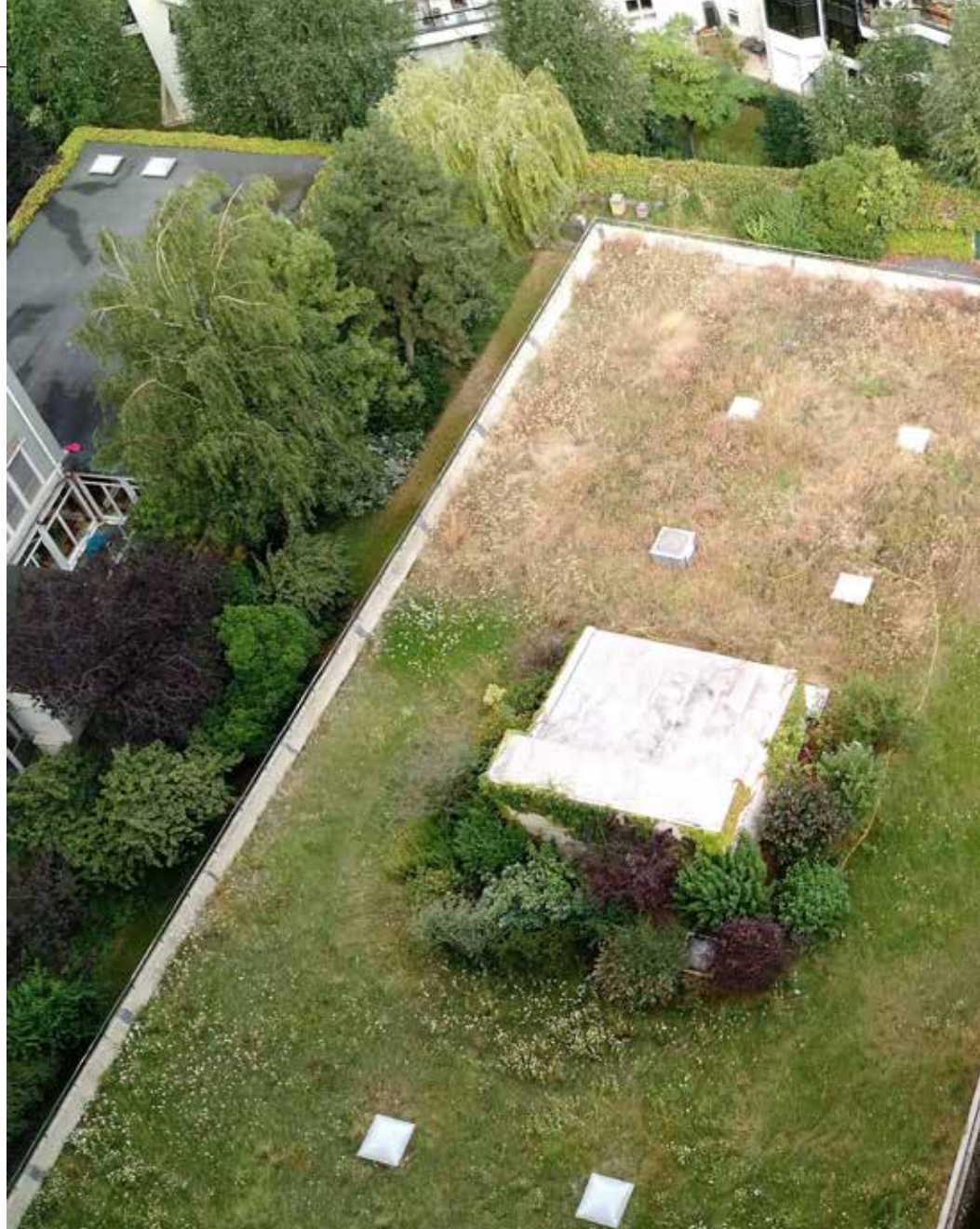
Cour et toit végétalisés, rue du Cotentin Paris XV e . Une prairie fleurie recouvre le toit du bâtiment de bureaux se trouvant dans la cour de la copropriété. Cette dernière, sous forme de U, rassemble une multitude d'aménagements pour la biodiversité : 3 ruches, des plantes mellifères, 1 hôtel à insectes, 15 nichoirs à oiseaux et 3 nichoirs à chauves-souris.
