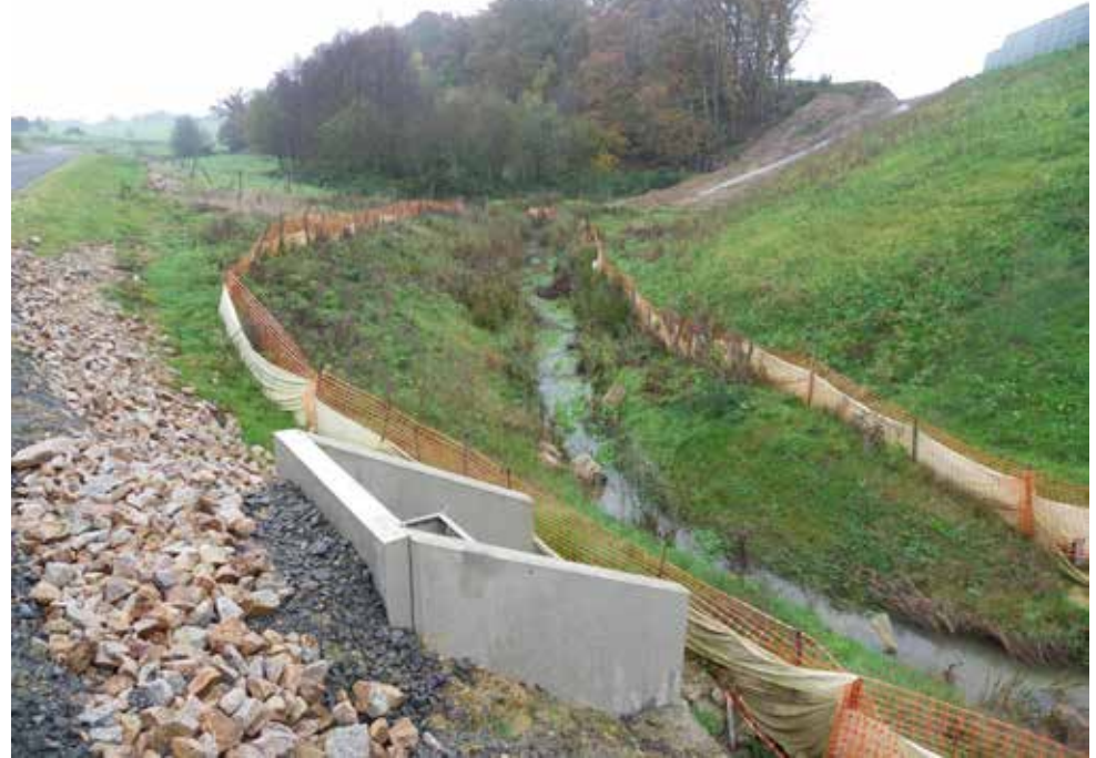
Figure 2. Réduction temporaire d'impact lors de la construction de la LGV Bretagne-Pays-de-Loire, la chenalisation d'un cours d'eau avant la finalisation d'un passage favorisant la continuité hydraulique.
