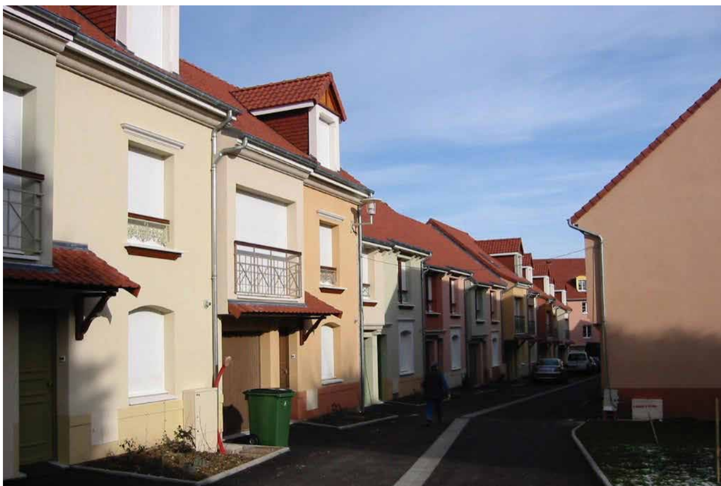
Maisons groupées en bande dans une opération réalisée à Amiens (Patrick Delamotte architecte).
