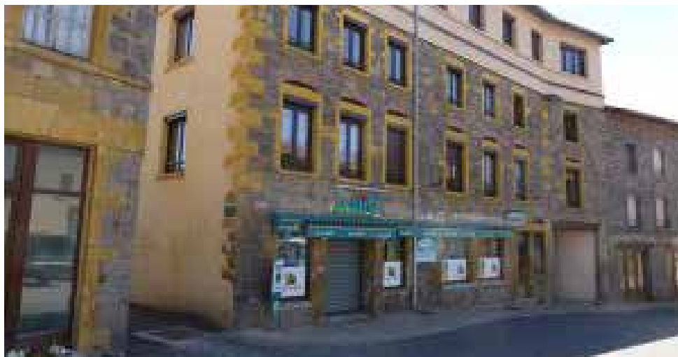
Transformation de sites à l'abandon. Montrottier (69) : rénovation/reconversion d'une ancienne clinique. Logements + commerces + espaces santé. Opération en cours (étude Virage).
