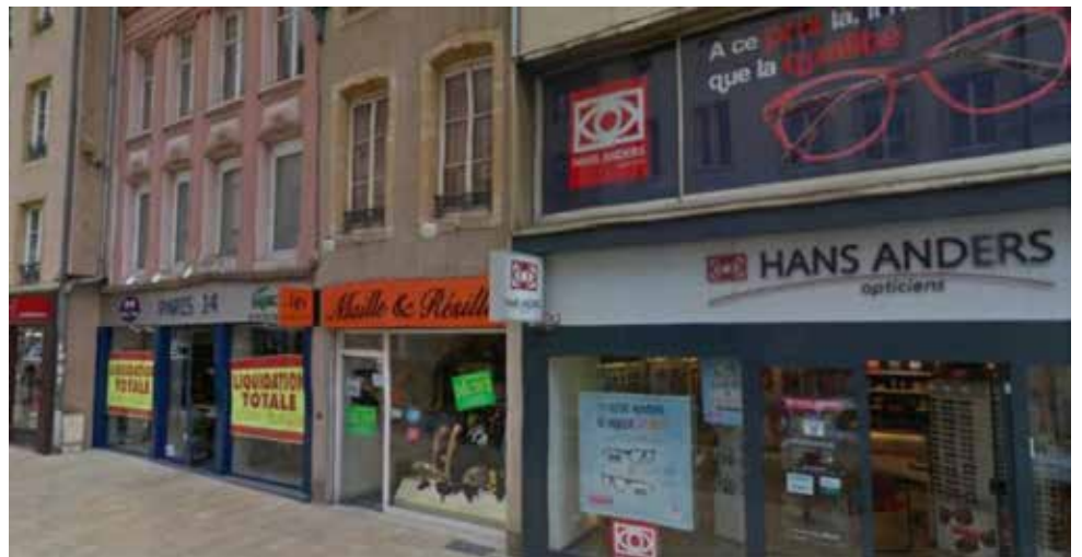
Centre de Thionville (57). Étages condamnés par les façades de magasins, eux-mêmes parfois vacants.
