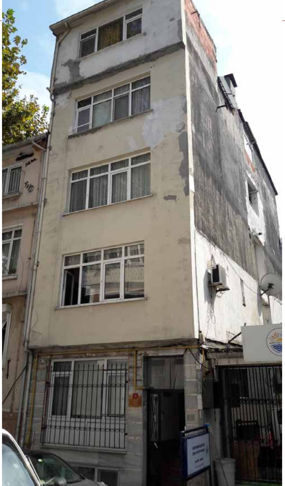
L'immeuble de Monsieur Kaptan, construit sans autorisation, étage après étage, année après année.
