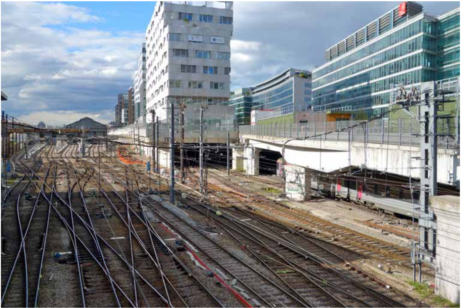
Vue vers le nord depuis le boulevard Vincent Auriol. De gauche à droite : la gare d'Austerlitz ; une rangée d'immeubles construits sur dalle au dessus des voies ; l'avenue de France au-dessous de laquelle passe un train ; une autre rangée d'immeubles construits en pleine terre.
