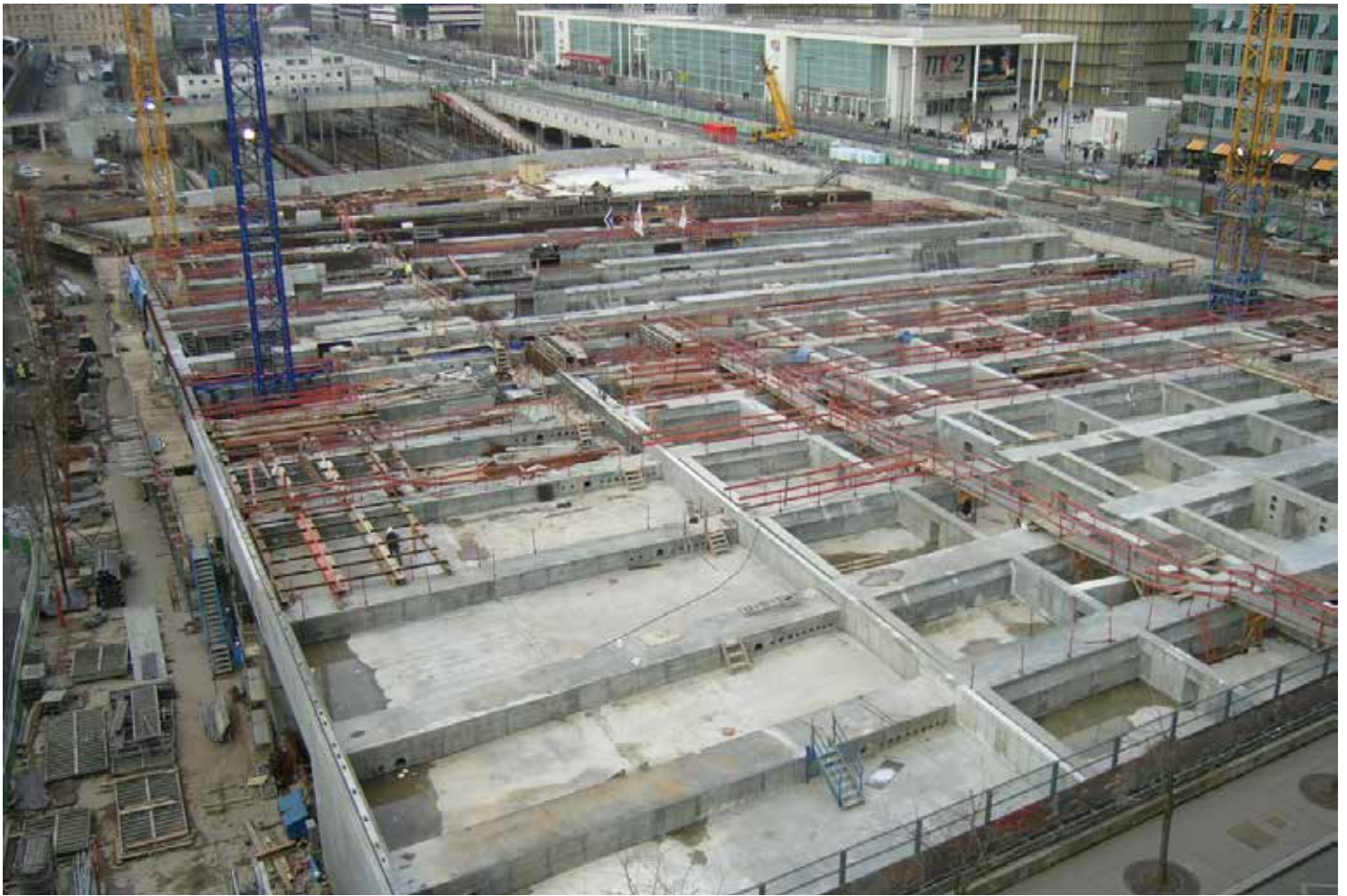
Vue vers le nord depuis la rue de Tolbiac. Dalles de couverture en construction, qui accueilleront des espaces publics et des constructions.
