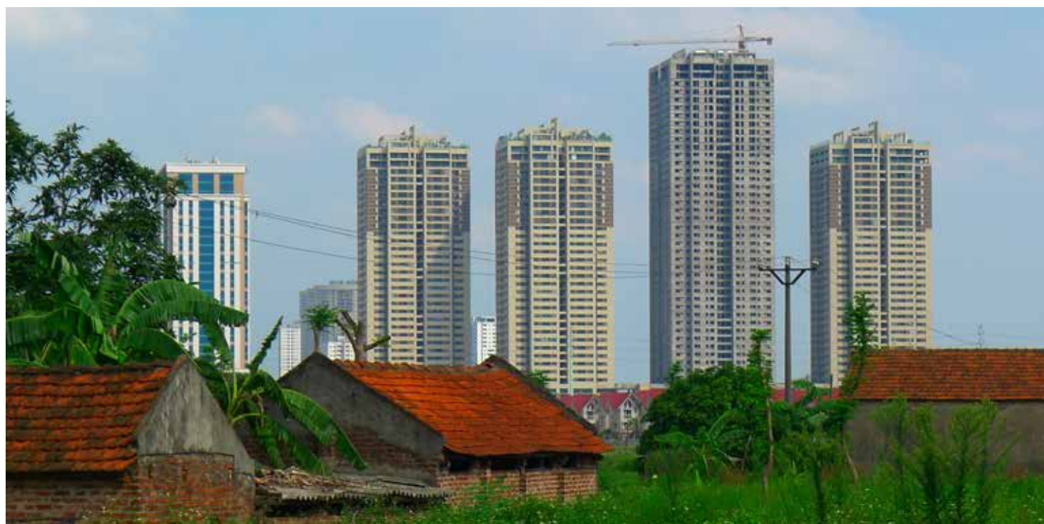
Hanoi : « nouvelles zones urbaines » en construction en périphérie de Hanoi, à proximité des villages existants (arrondissement de Ha Dong).
